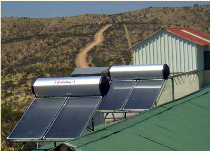
**Abb. 4: Die Strahlung der Sonne erhitzt das Wasser in den Solarthermen.
