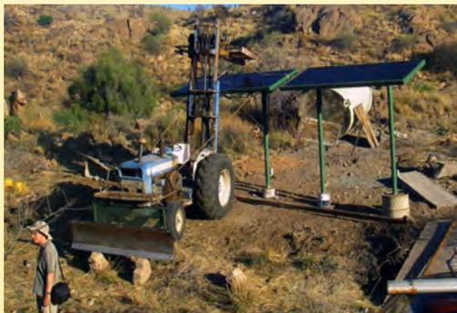
Abb. 20: Solarzellen für die Elektropumpe am neuen Bohrloch.
