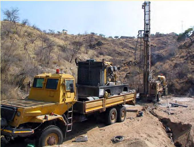
**Abb. 15: Bohrung am Nutzwasserbohrloch. Foto: R. Glawion.**
